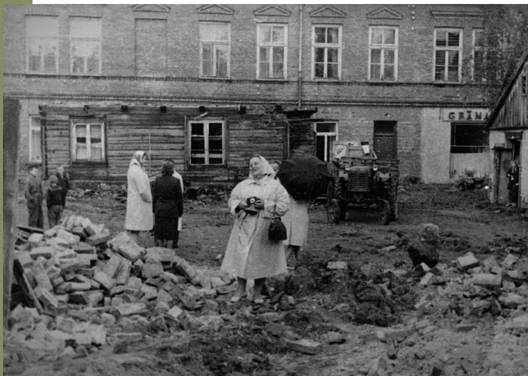
Vecās koka apbūves nojaukšana A.Bahmaņa (Parka) ielā pretīm kultūras namam 1950.-to g. beigās
